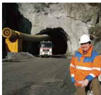
Tunnelbyggjar: Rolf Harkestad var prosjektleiar for bygginga av E39 Uføretunnelen i Hordaland. (Arkivfoto: Geir Brekke)
