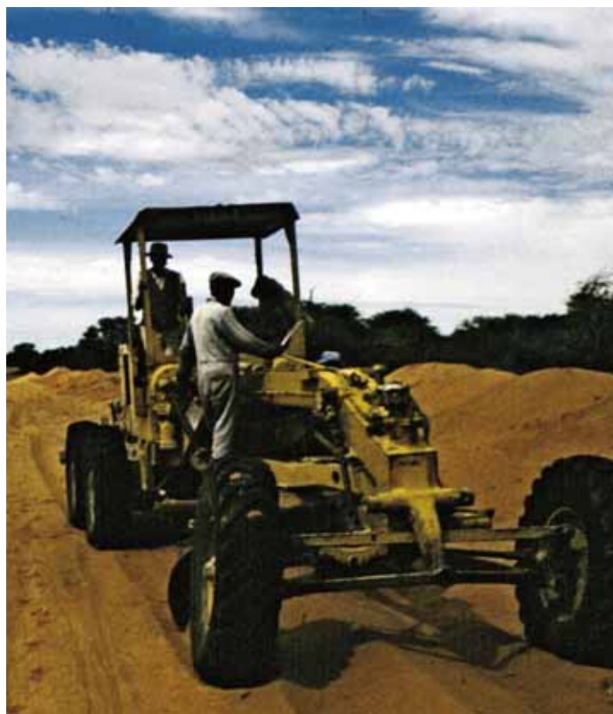
Vegbygging: Langt fra moderne anleggsdrift i Botswana. (Foto: Statens vegvesen)
