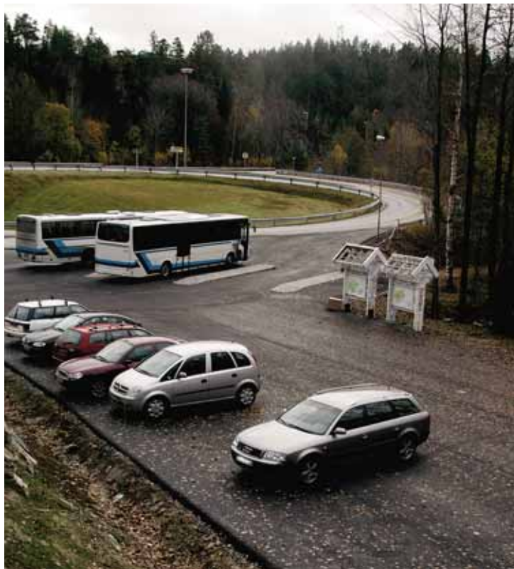
Utbedret: Bussholdeplass på E18 Vinterkjær ved Risør er akkurat utvidet og utbedret nå i høst. (Foto: Kjell Wold)
