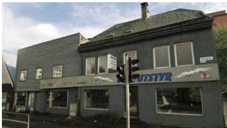
Rivenekt: Byantikvaren nekter riving av disse to husene, og Statens vegvesen blir dermed inntil to år forsinket med bygging av en ny og viktig avlastningsgate i Bergen. (Foto: Geir Brekke)
