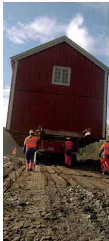
På flyttefot: Den fredede gamle skolen flyttes for å gi plass til ny riksveg i Midtre Gauldal. (Foto: Knut Opeide)
