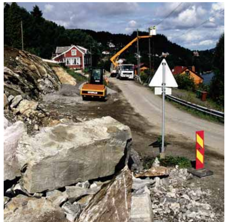
Får smal til brei: Skrevegen var bygd for hest og kjerre, men blir no ombygd til tofeltsveg med gang- og sykkelveg. (Foto: Geir Brekke)
