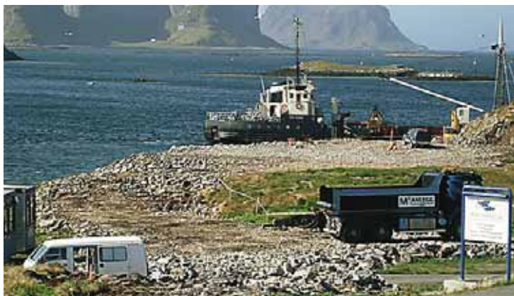
Inngang: Her bygges den nye ferjekaia. (Foto: Kjell Sture Trymbo)
