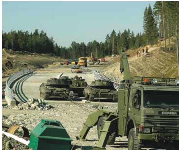
Dimensjonerende krefter: For å simulere kraften av et bremsende vogntog ble tre stridsvogner satt oppå Langbakk bru og trukket med innpå 100 tonns kraft. (Foto: Elin Lied)
