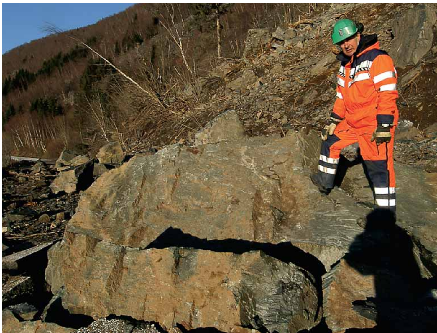
Store rasblokkar: Entreprenøren sin kjentmann Svein Kai Fedje med steinmassar som kom ned på vegen 5.februar i år. (Arkivfoto: Geir Brekke)
