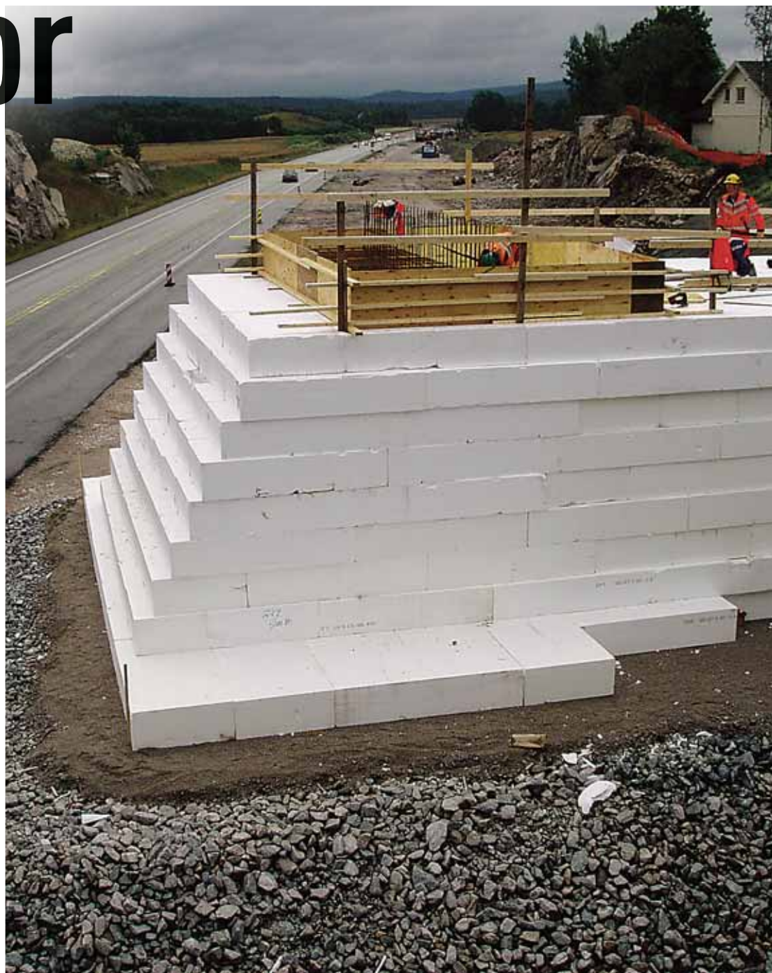
Vegger på isopor: Takket være en genial idé fra en vegvesenmann, bruker mange land EPS-blokker eller isopor når de skal bygge vegger etc. Et lett byggemateriale som holder bra. (Foto: Tor Helge Johansen)
