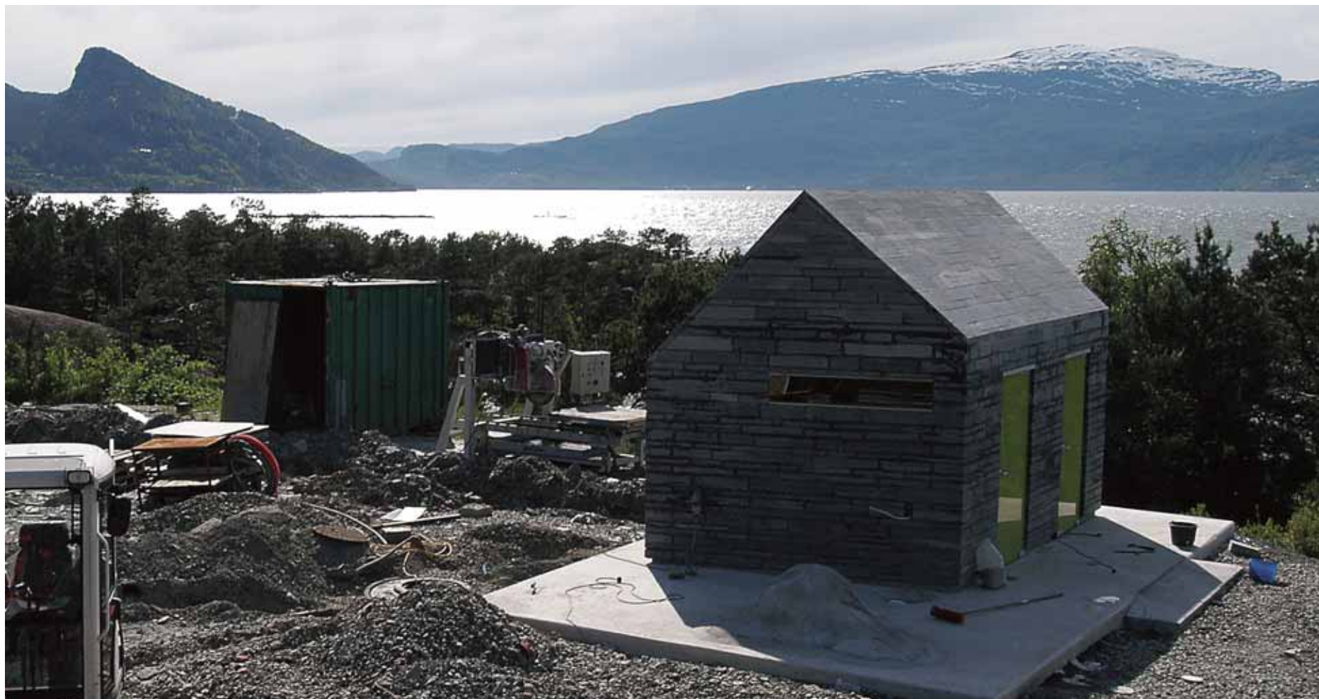
Sjeldan fugl: Service-huset er bygt i finskoren skifer med gule glassdører. (Foto: Geir Brekke)
