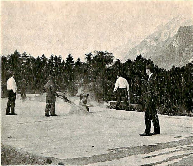
Fig. 1. Bortsliping av ujevnheter på betongdekket.
