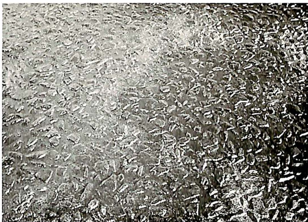
Fig. 5. I det färdiga CM-bärlagret bör bindebrukets yta mellan makadamstenarna ligga något försänkt i förhållande till dessa så att asfaltbeläggningsen blir förankrad direkt i makadamstommen (Kristianstadvägen).
