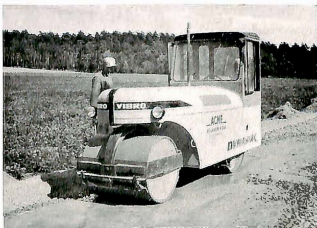
Fig. 4. Det effektivaste sättet att nedbringa det utbredda bruket i makadamlagrets hålrum är att vibrovälta lagret. Valsarna tränger lokalt undan bruket och ligger an mot makadamlagret som sättes i vibration, varvid bruket nedtränger med stor lätthet (Kristianstadvägen).
