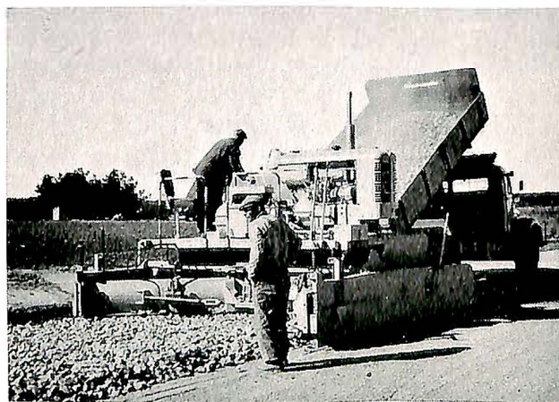
Fig. 1. För att grovmakadamlagret skall bli så homogent och ytan så jämn som möjligt är det fördelaktigast om makadamutläggningen kan ske maskinellt (Laholmsvägen).
