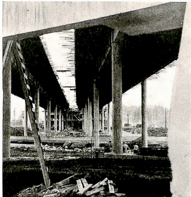
Fig. 1. Uppsalavägen. Bru av forspente betongbjelker.
