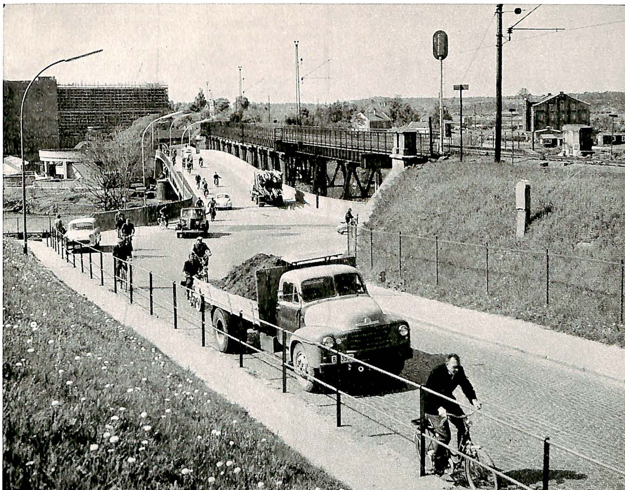
Fig. 1. Innføringen av riksvei 1 til Sarpsborg over den smale bro over Sarpsfossen.
