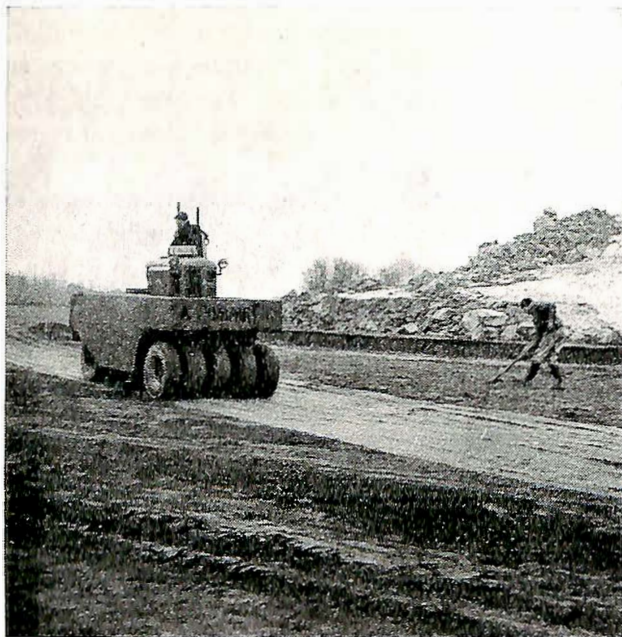
Fig. 4. Komprimering med gummihjulvalse.
