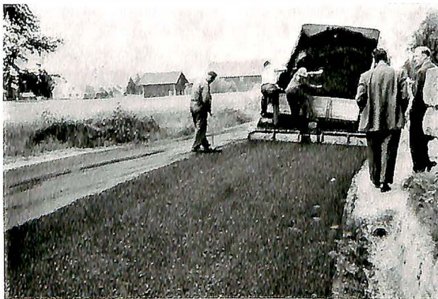
Fig. 2. Utbygging av topplag (25 l/m 2 ) på riksveg 80 i Solør.
