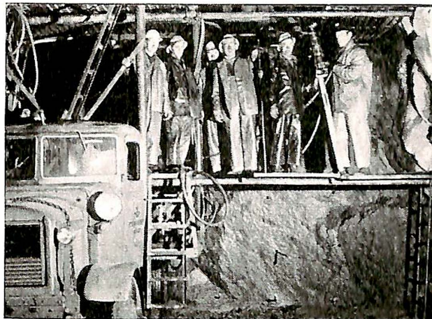
Fig. 3. Tunnelarbeiderne er kommet på plass.
