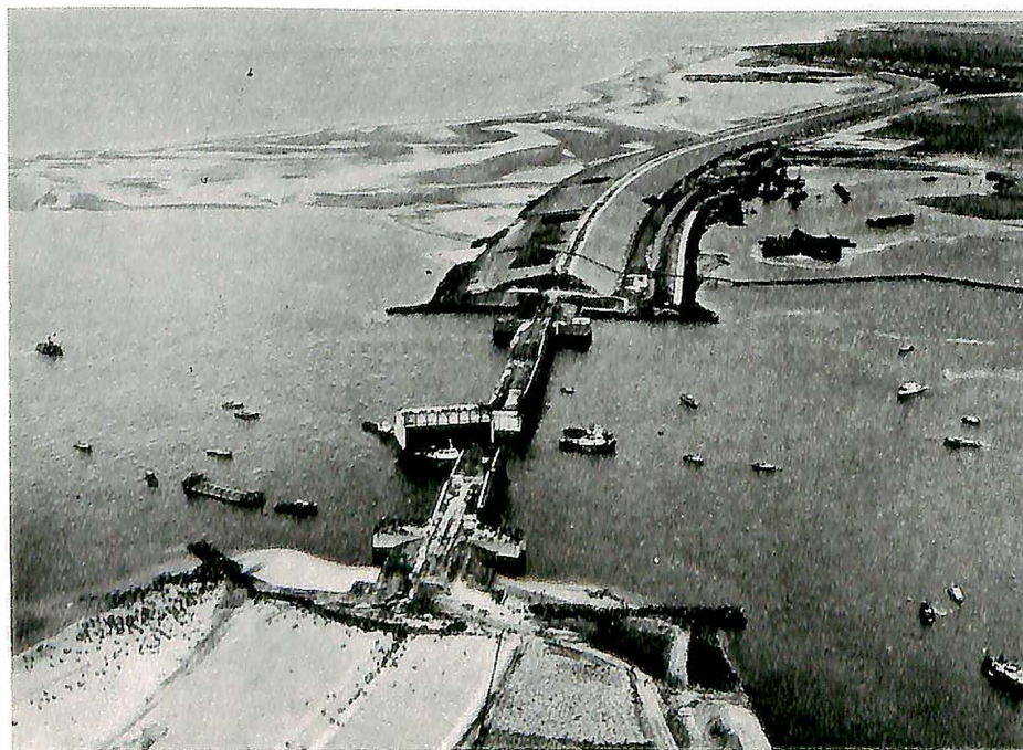
Fig. 2. Den siste senkekasse bringes på plass i dammen over Veerse Gat. Dermed er 1. trimn fullført i den store Delta-planen, som skal forhindre en gjentagelse av de store oversvømmelsene i 1953.
