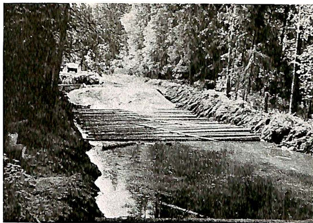
Fig. 5. Gyllermyra. utlegging av sagflis.
