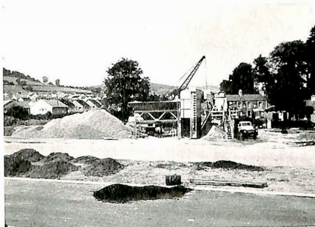
Fig. 1. Blandeanlegg for magerbetong til bærelag på veg i Glamorganshire. Det ferdige bærelag for halve vegen kan sees i forgrunnen.
