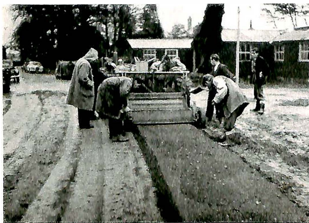
Fig. 5. Soilcement legges på en boliggate med et 4 ft. Howard Single Pass Train.
