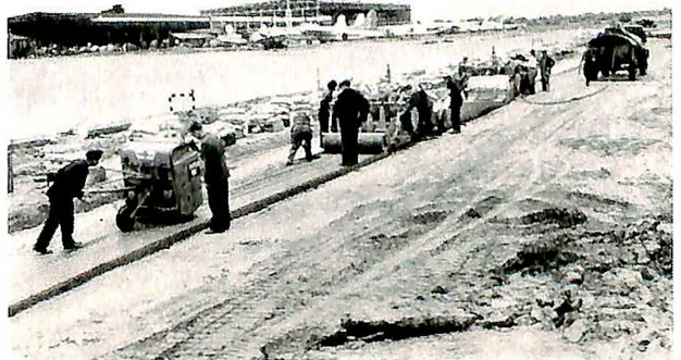
Fig. 4. Soilcement legges på en rullebane på Guernsey flyplass med et 4 ft. Howard Single Pass Train.
