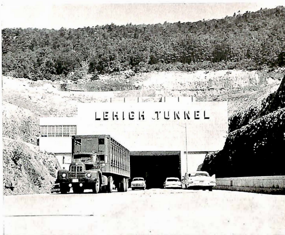
Fig. 2. Lehigh-tunnelen for nord-armen av Pennsylvania Turnpike. Denne tunnelen vart opna 1. april 1957.
