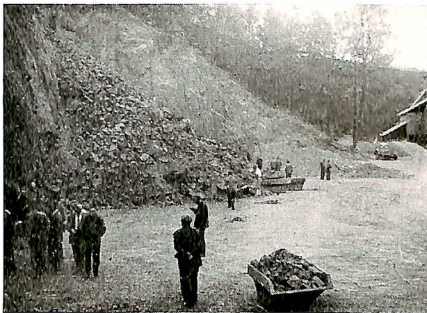
Fig. 4. Nieder Beerbach steinbrudd og knuseverk ved Frankenstein (Odenwald), hvor en tar ut gabbroide bergarter til vegdekkematerialer.
