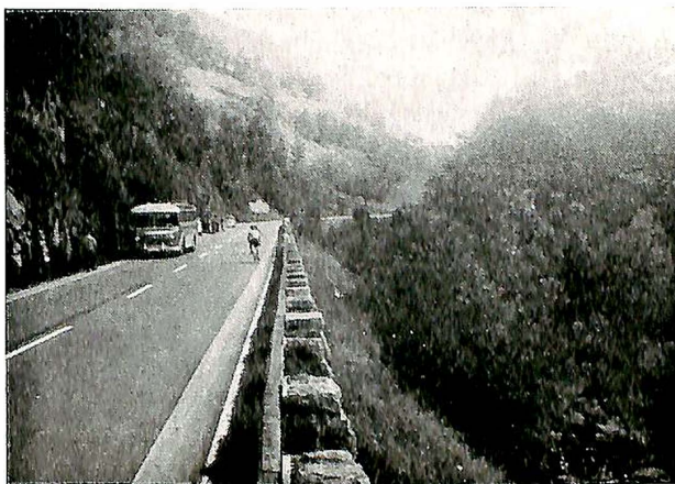
Fig. 5. Sekundær hovedveg, mellom Mannbach og Schöna (Schwarzwald); mørkt, godt asfaltdekke med sterkt steinmateriale, og med 40 cm brede lyse asfaltbanketter med svakt steinmateriale (kalkstein), foruten hvit kantstein ytterst.
