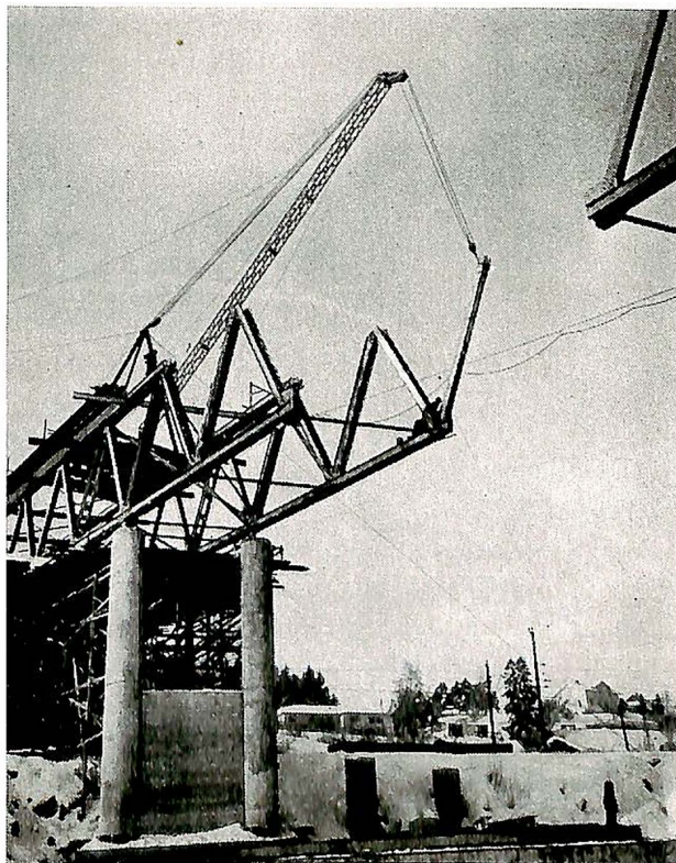
Fig. 4. Montering av stålfagverket.
