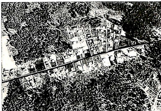
Fig. 2. Karlshus haveby ved riksveg 1 i Østfold med 60 m byggelinjeavstand.
