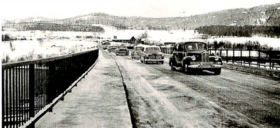
Fig. 1. Bilkortesje over Minnesund bru etter åpningen.
