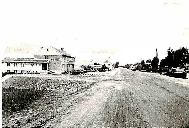
Fig. 4. Riksveg 1 syd for parsellen vist i figur 3. Her er den gamle veglinje beholdt. Ved hjelp av samlevegger etc. har en forsøkt også her å få en avkjørselsfri riksvegstrekning, men det viser seg meget vanskelig i praksis. Vegen beholder fortsatt sitt preg av å være den lokale hovedåre gjennom stedet. Bolighusene, forretningene etc. ligger fortsatt vendt ut mot riksvegen, og den tar da også preg av det. På tross av de utbedringsarbeider som er gjort har en fortsatt følelsen av å kjøre gjennom tettbebyggelse og at en bør redusere sin kjørehastighet.
