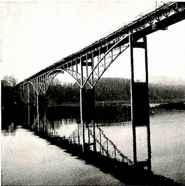
Fig. 7. Brua ferdig montert.
