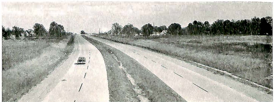
Fig. 4. Ein vanleg motorveg i U.S.A. Der er 2 vognbaner (2 l m) + 3 m breid bankett i kvar k yreretning. Mellom dei to k yreretningane er der breid fersenka skiljeremse, «Median».
