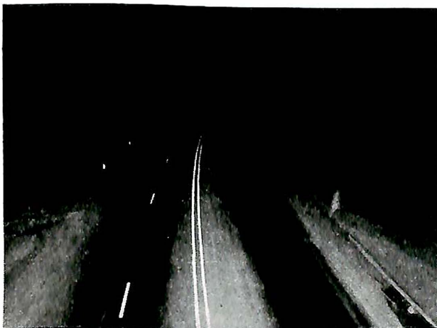
Fig. 2. Samme sted som på fig. 1 fotografert fra bil om natten viser refleksjonen fra stripene og fra vegstolpene.
