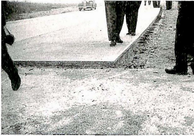
Fig. 7. Ved Weinlandbrücke. Dekke ferdig støpt med dybler for sidekant.
