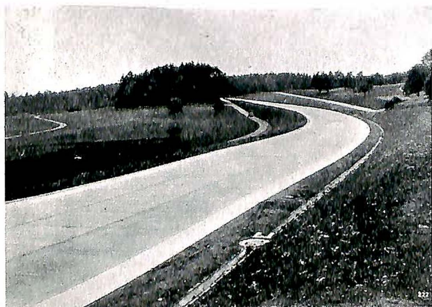
Fig. 10. Vegen Winterthur—Schaffhausen i Sveits, ferdig 1957. 20 cm tykt betongdekke, 3 kjørebaneer à 3 m + 2 × 1 m, i alt 11 m bredde. Kantene er støpt med hvit sement.
