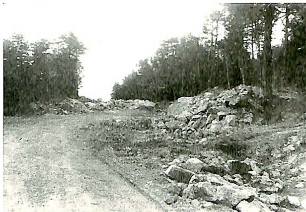
Fig. 3. Skjæring tatt med millisekund salve. Lastes opp med gravemaskin.
