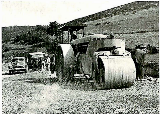
Fig. 17. Nytt pukkberelag «vannes» og vales. Vegen Larissa—Aten.
