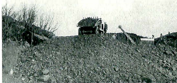
Fig. 8. Tipping fra dumper. Gode steinmasser for maskinlastning. I begynnelsen var det en del uhell p. g. a. dumpersene kjørte utfor tippen. Derfor anvendes store boks som sikring.
