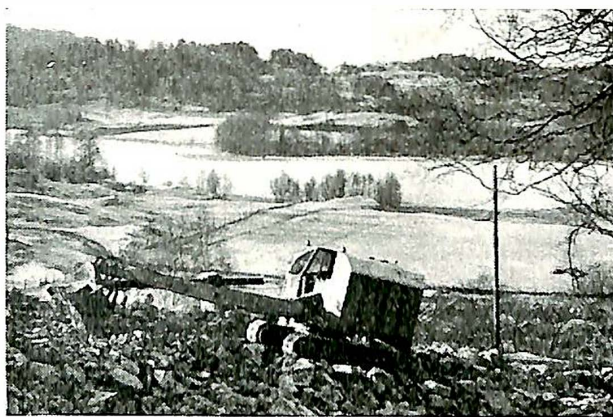
Fig. 6. Gravemaskin forflyttes over en utsprengt fjellskjæring. Den rygger og anvender skuffen som bremse. Gravemaskinene kommer bedre frem i terrenget enn dumpersene, som de ofte måtte slepe etter seg.
