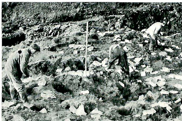
Fig. 5. Ladning for en salve på flyplassvegen. I hver salve ble gjennomsnittlig uttatt 500 m 3 fjell med 3—400 kg dynamitt.
