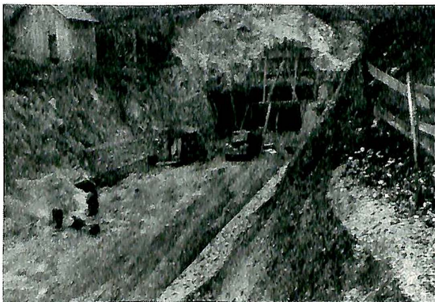
Fig. 3. Tunnelinnslag på autoput Zagreb—Ljubljana i Jugoslavia.
