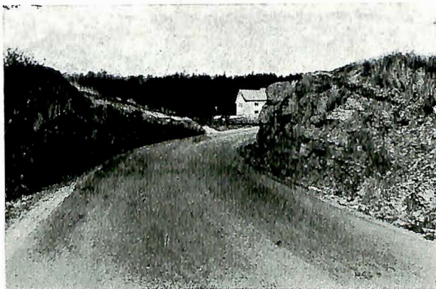
Fig. 7. Utbedret parti mellom Sundvollen og Hønefoss.
