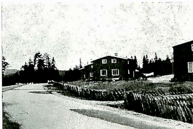
Fig. 5. Utbedret parti på riksveg 70. Randbebyggelse under utvikling.
