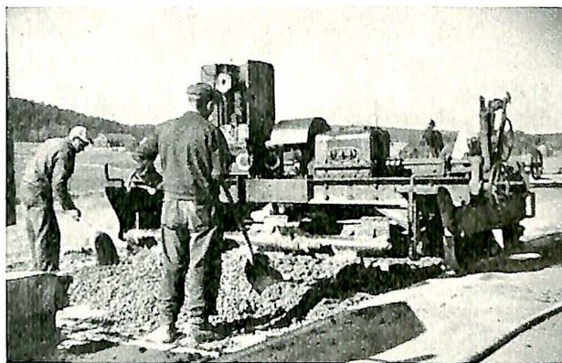
Fig. 5. Legging av fast vegdekke på Hemsletta på sørlandske hovedveg 1952.
