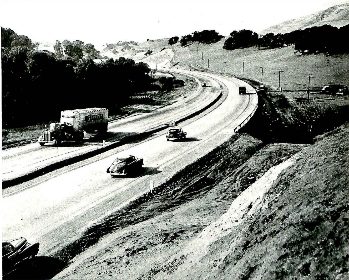
Fig. 66. Den gamle — sagnomsuste highway US 40 er i California utvidet til 2 kjørebane i hver fartsretning — midtstripe og banketter. Vi må se å komme i gang med noe i den retning.
