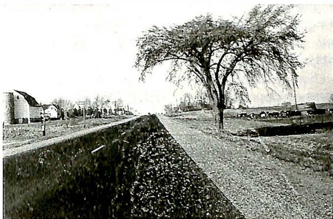
Fig. 64. Den gamle veg med 16' betongdekke er utvidet til 22' kjørebane med asfalt-grusbetongdekke og overflatebehandlde banketter 5' brede.
