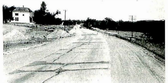
Fig. 62. Breddeutvidelsen er ferdigkomprimert.
