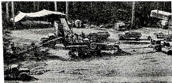
Fig. 2. Transportable steinknuser og annet utstyr for vegbygging.
