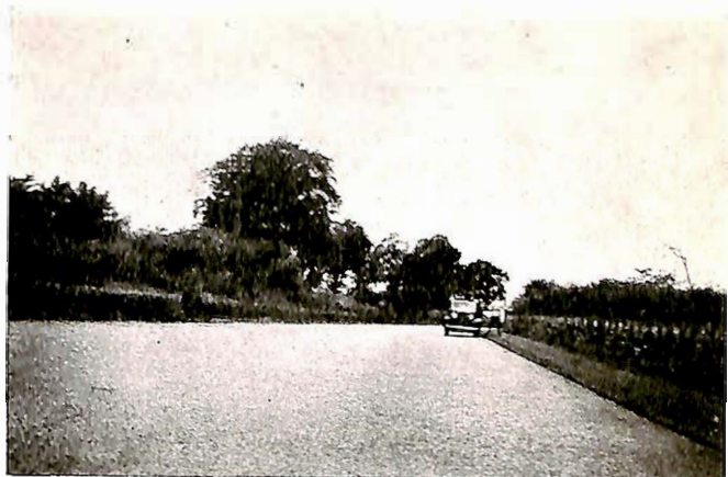
Fig. 12. God tjæreoverflatebehandling.
