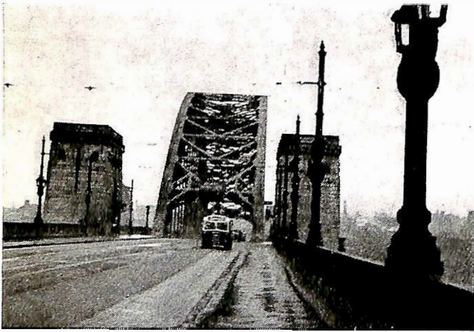
Fig. 4. Tyne broen, Newcastle. Merk det tette og rotete vindfagverk.
