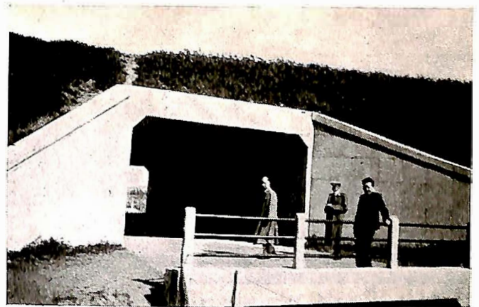
Fig. 4. Kombinert bru og krotterundergang.
