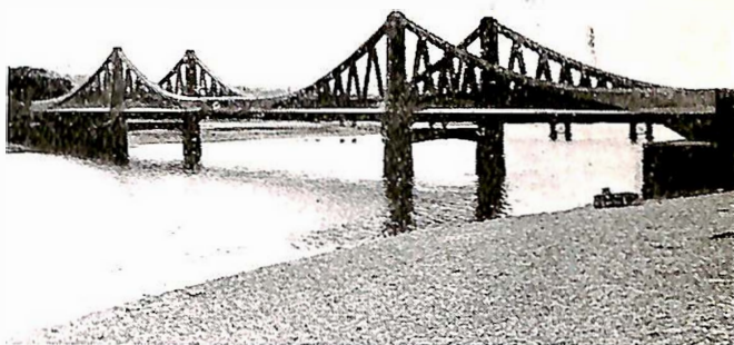
Fig. 7. Betongbru i Montrose. Overflaten er prikkhogd. Mange sprekker i betongen.
