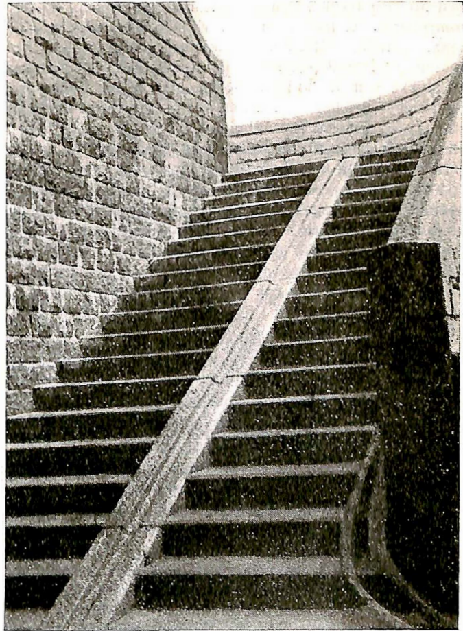
Fig. 11. Tropp opp til gongvegane på brua over Rhinen i Arnheim. I Holland lagar dei ei slik renne midt etter kvar tropp for at det skal vere lett å trille sykane opp og ned troppa. Dette burde Holmenkollbana kjent til da dei bygde troppa over bana ved Frøn st. for snart 10 år sidan.
