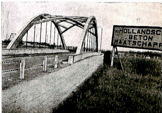
Fig. 9. Ei bogebru av armert betong nær Haag. Denne brua er allt teken i bruk.
