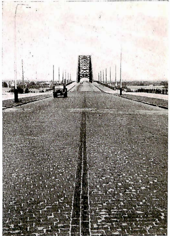
Fig. 4. Vegdekket av naturstein (basalt) på forløpsvegen til den store brua over Rhinen i Nijmegen, 244 m midtspenn har denne brua, som ikkje vart sprengd under krig og invasjon.
