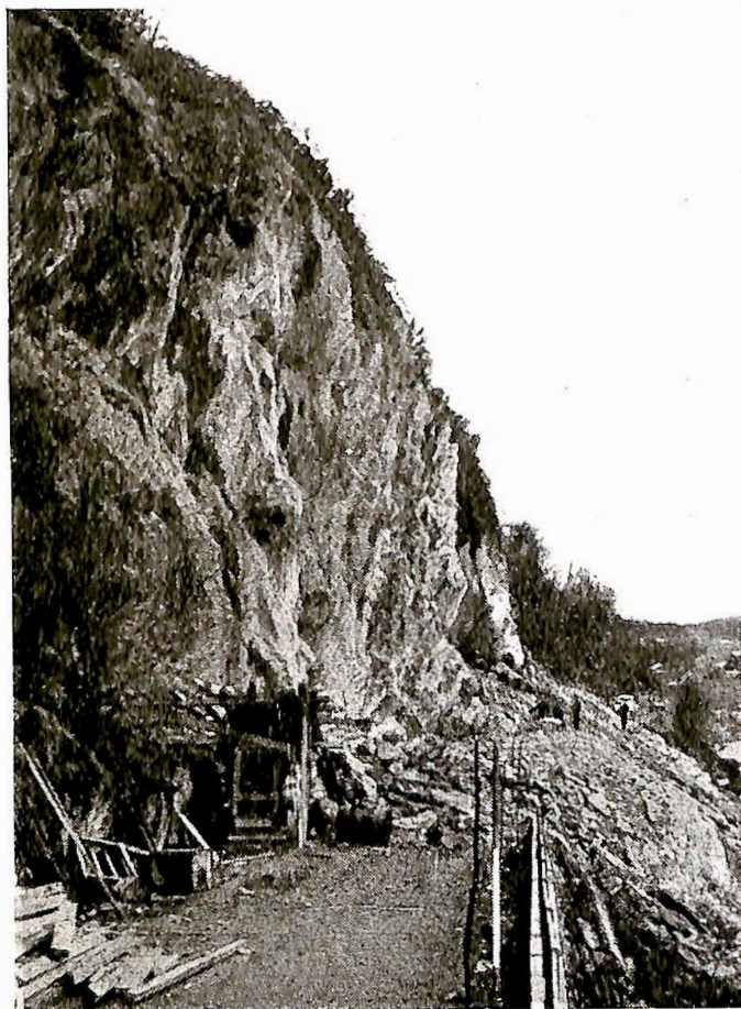
Fig. 6. Ryddingsarbeid pågår. Sett fra sør.
