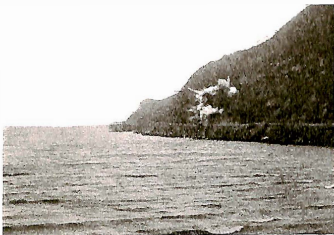
Fig. 5. Første fase i sprengningen: «Toppene» tas av med serie A—B.
