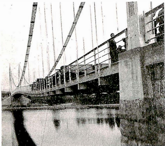
Fig. 1. Brandval bru under prøvebelastning.
