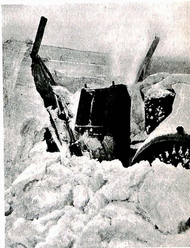
Fig. 4. Gjennom 3.0 m brøytekant.
