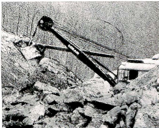
Fig. 1. Skje-graver tar ut sprengte steinmasser.
