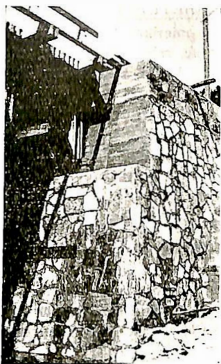
Fig. 4. Haugsjåsund bru. Detalj av landkarr.
