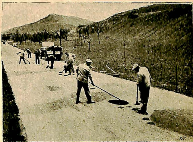
Fig. 3. Flekkklapping på asfaltdekker.
