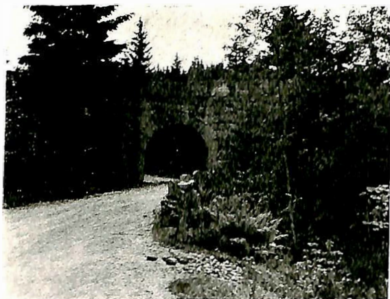
Fig. 3. Knuten i Langangen, bygget i 1859, nå revet, avløst 2. januar 1941 med ny.
