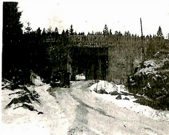
Fig. 4. Kokkersvoll bru. Ny bru med den gamle i bakgrunnen.
