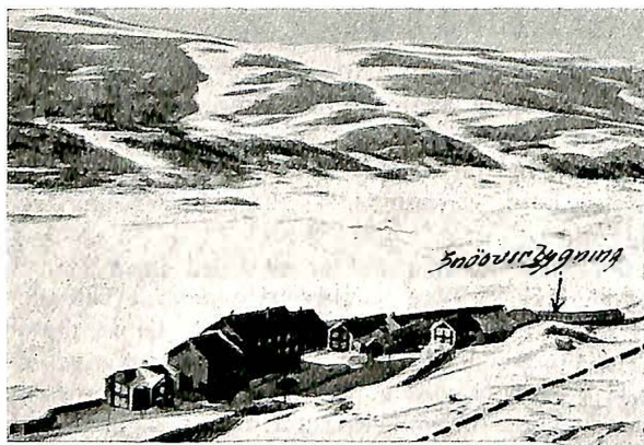
Snøoverbygning og veiregulering ved Nystuen på Filefjell. Den prikkete linje viser den nye, i arbeid værende, veilinje som ventes å ville spare oss for snevanskeligheter.
