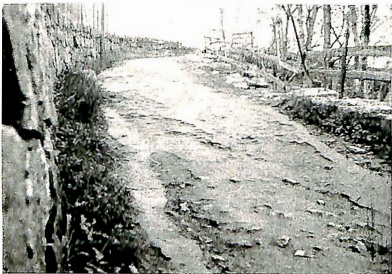
Hukebakgangen («Kjærlighetsstien»). Her kan det antas at den eldste Vestfoldvei har gått opover fra bru ved Nedre Fos. Karakteristisk vei fra middelalderen med slitasje synlig i fjellgrunnen og rester av den gamle veimur tilhøre.
