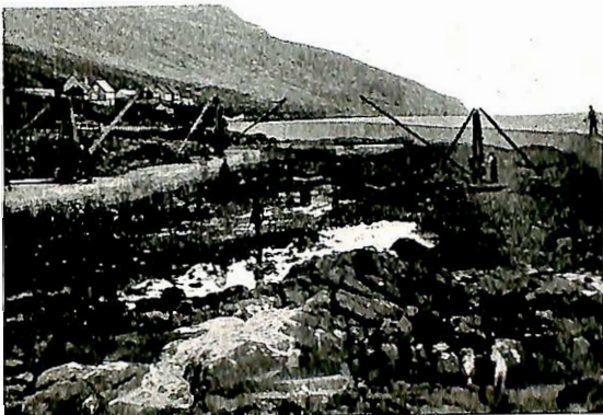
Et havneanlegg. Det er bygget en demning, vannet er pumpet ut og bunnen rensket op.
