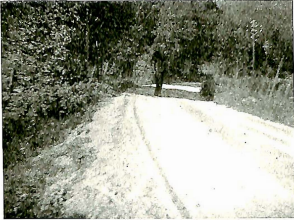
Hvor er rekkverket?
