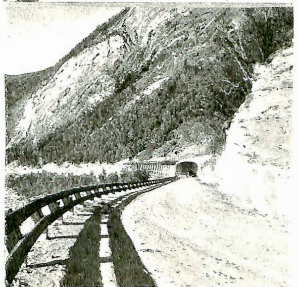
Overbygging i Kvenflaget i veianlegget Finneid—Rognan.
