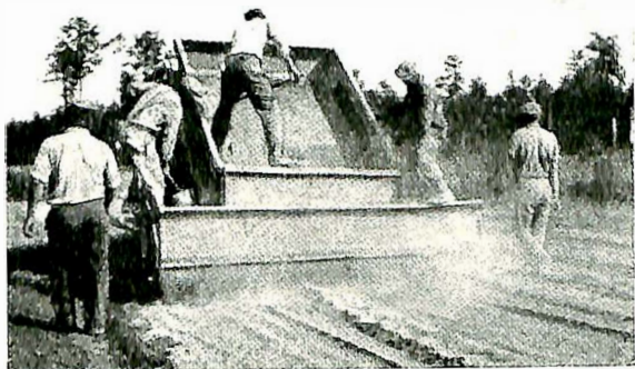
Fig. 1. Utspridning av cement för cementstabilisering av undergrunden.
