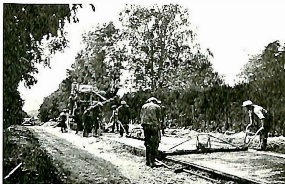
Fig. 6. Legging av vibro-betongdekke i Asker.
