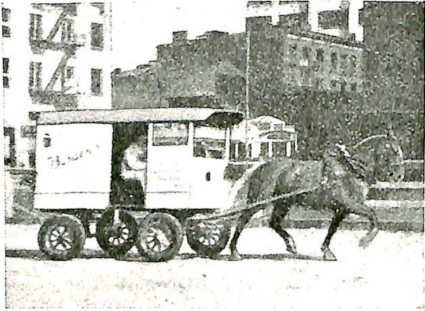
Fig. 2. Melkevoan med luftgummihjul.
