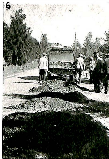
Fig. 5. Massen tippes fra vaggjen ned i lastebil. Fig. 6. Mortelen legges i hauger på veibanen. Fig. 7. Massen jevnes ut med veiøvel.
