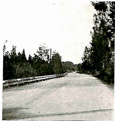
Fig. 8. Det ferdige veidekke.
