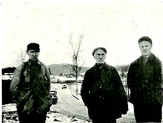
Fig. 2. Den nye bro sees i bakgrunnen. Brobanen er nu lagt med samme stigning som veien på begge sider.
