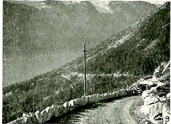
Fig 7. Mur under bygging. „ 8. Betongrekkverk langs gjuv. „ 9. Veiparti med utsikt mot Folgefonna på vestsiden av Sorfjorden.
