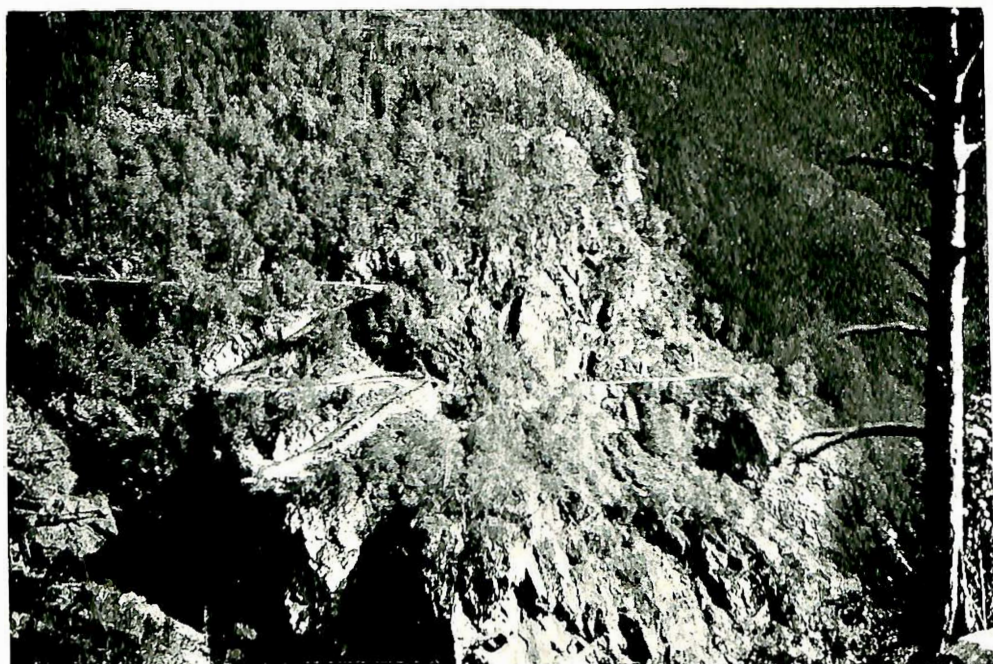
Fig. 2. Slyngparti av turistveien til Skjeggedal (bygget 1904).
