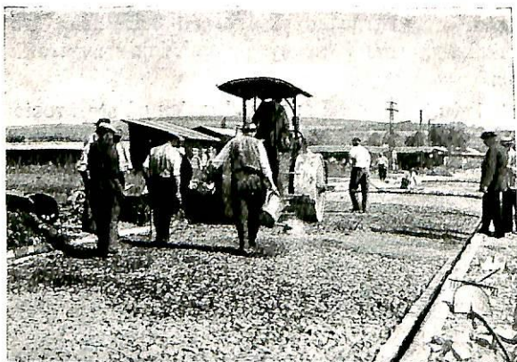
Fig. 1. Det nedste pukklaget, som fyrst er lett valsa, blir her overdusja med vatn. So blir eit 5 cm tjukt mørtellag breiddt ut og det øvste pukklaget lagt på. I stykke på ikring 10 m blir no dette øvste pukklaget valsa ned.
