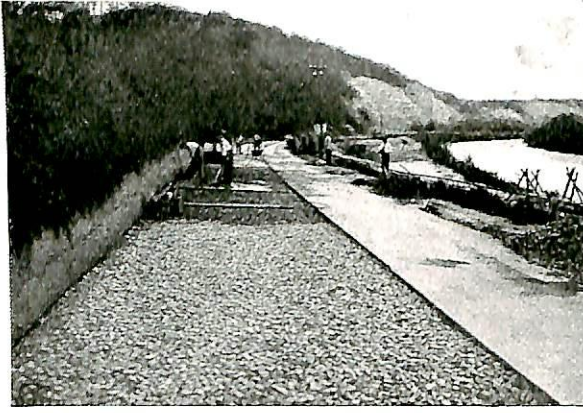
Fig. 4. Dette sement-pukk-dekket på vegen Münster—Mühlhaus blir bygt i to teigar. Den fyrste teigen, høgre veghalva, er ferdig. Den andre teigen, vinstre veghalva er her i arbeid. Nærmast ser vi nedste pukklaget. Lenger burte legg dei andre pukklaget ovanpå mortellaget. Burtanfor der att held dei på med valsing og tetting av vegdekket.
