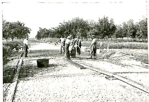
Fig. 3. Leggjing av sement-pukk-dekke ved Wiesbaden-Hochheim. I framgrunnen ligg ein tverrplanke der utvidningsfuga skal bli. Han ligg i underpukken. Burtanfor legg dei sementmørtel og deretter ovste pukklaget.
