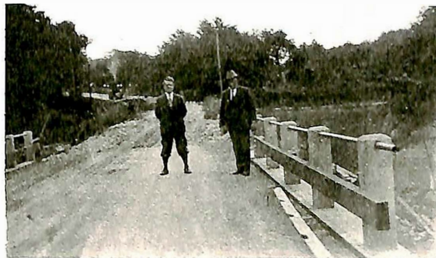
Rekkverk på ei gamal bru i Båhusen.
