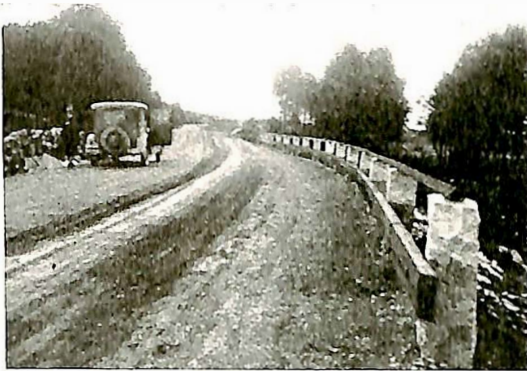
Rekkverk på den umlagna vegen gjennom Båhusen.
