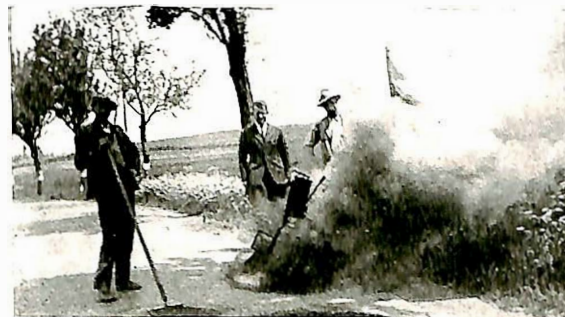
Øvst: Varming av vegtjære i Luxembourg. Nedst: Asfaltvøing med flammekastar og stålrive i Luxembourg.
