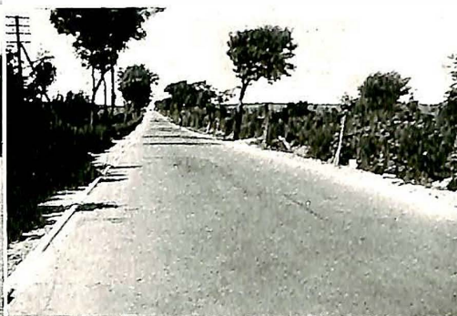
Hovudvegen frå Tyskland mot Aabenraa. Her var arbeid med å leggja asfaltbetong på sykkelbana som er avgrensa frå køyrebana med låge avbrotne betongkantar.
