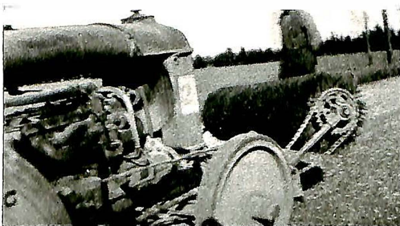
Fordson (traktor) ombygd til sopemaskin. Brukt til soping av vegane i Danmark.
