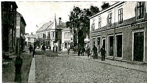
Fra arbeidet i Kongens gate, Steinkjer. Kultlaget ferdigvalset, pukklaget utlagt og ferdig til å behandles.
