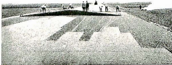
Fig. 5. Leggjing av tjærepukkdekke.
