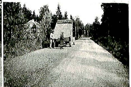
Overflatebehandling. Spredning av singel.
