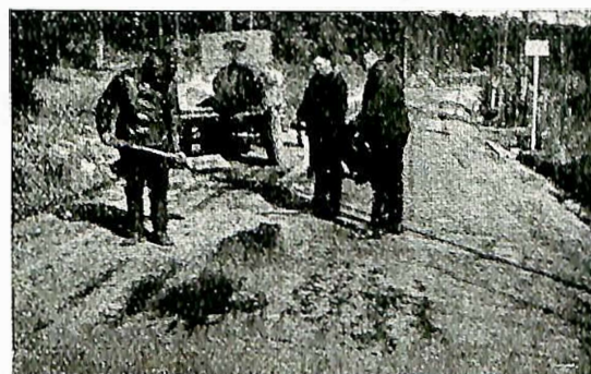
Fig. 4. Lagning av isär på vägbanan, orsakad av „tjällskott”. April 1933.
