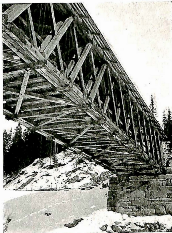
Unset bro, Øvre Rendal. 14 \times 2,071 = 29 m teor. sp.vidde. Bæreveggshøide = 3,22 m, bæreveggsavstand = 3,80 m.
