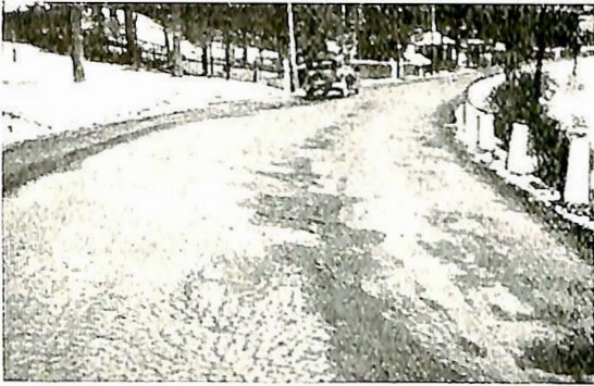
Fig. 1. Stensatt vägbana i stockholmstrakten efter tjällossningen, våren 1933.
