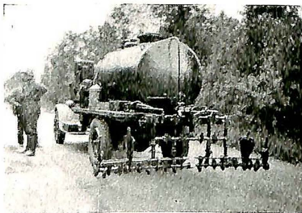
Tankvogn, Gassverket leverer tjæren varm fra destillasjonen og utspredd.
