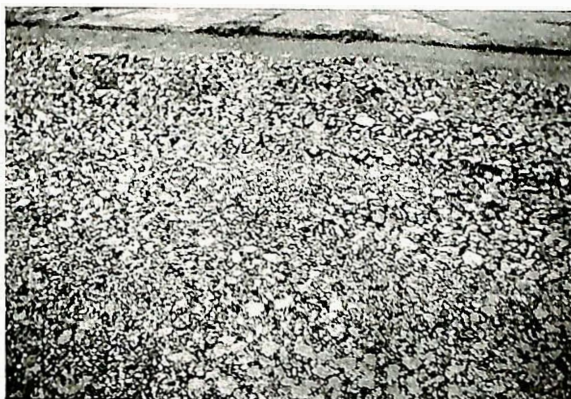
Øverst: 20—45 mm grovsingel nedvalset i det løse gruslag. Nederst: Forsterket pedrolittdekke på Langbrodalsveien. 3 cm nedvalset stenlag ferdig til penetrering med tjære.
