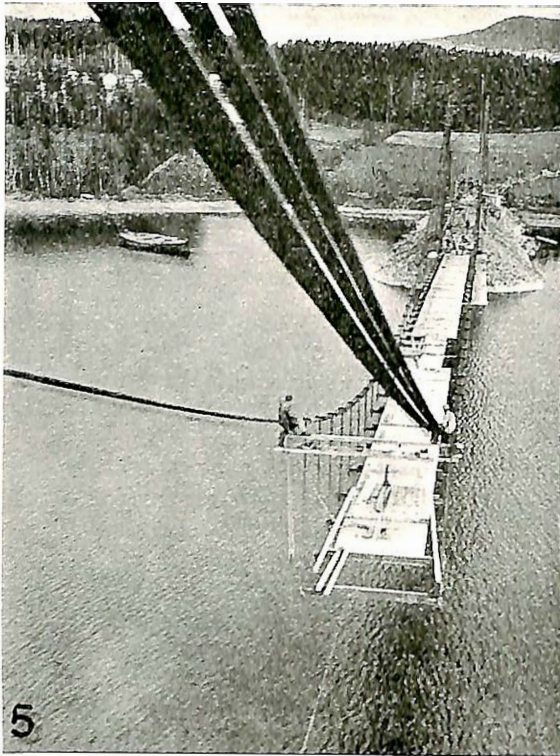
Fig. 5 Montering av hengestenger og tverrbærere.
