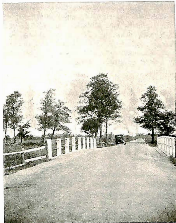
Nær Kalmar. — Semigrouting med asfaltermulsjon.
