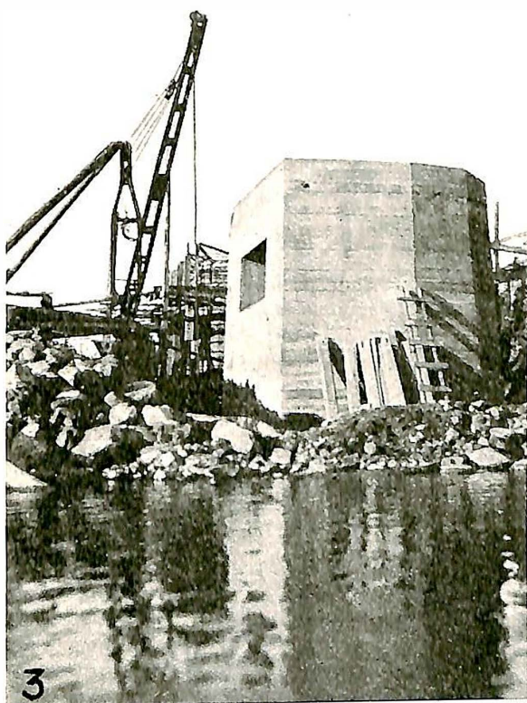
Fig. 3. Betongbrønn før senkningen.
