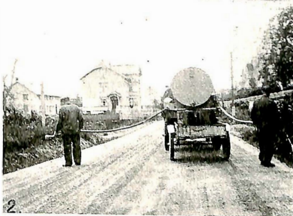
1. 2000 liters tank for spredning av natriumklorat. Unipumpe med 1½ HK. motor. Tilhenger for jerntromler. 2. Spredning med 2 slanger.
